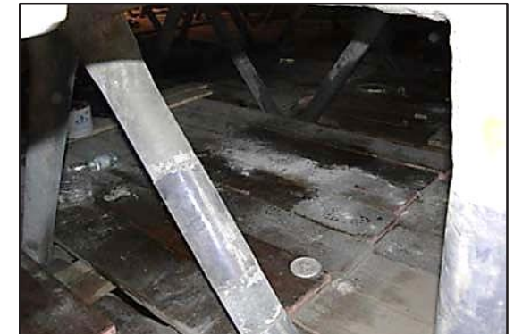
Instalado en servicio.
