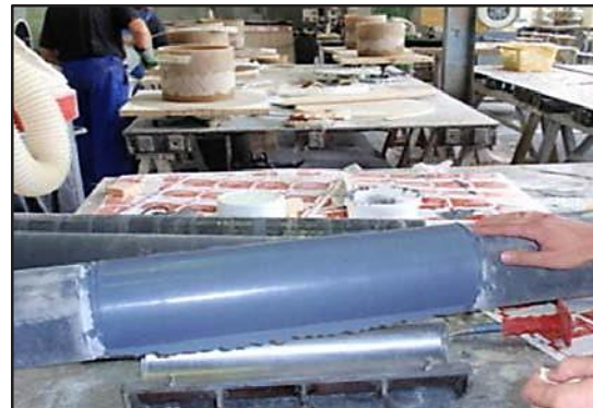
Aplicación del revestimiento ARC con molde.
